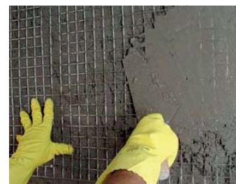
Reforço de Argamassa
